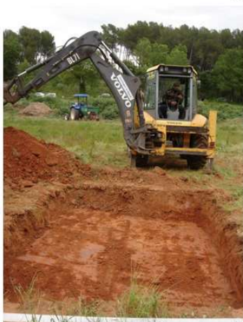
Faire une fosse de 15 m 2 et 50 cm de profondeur
