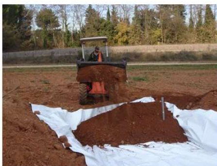
Pose d'une bâche étanche et d'un piézomètre
